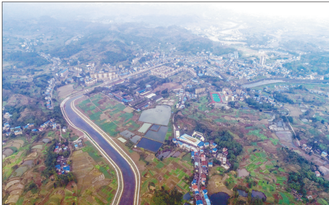
四川省华蓥市近年来同步开展华蓥市庆华镇段防洪治理工程与庆华镇供水管网工程建设，并进行综合治理。通过浇筑河道堡坎、安装污水管道、修建污水处理站等，净化流域环境，提高防洪能力，使水清岸绿环境更美，成为人们休闲观景的好去处。 人民图片网供图
