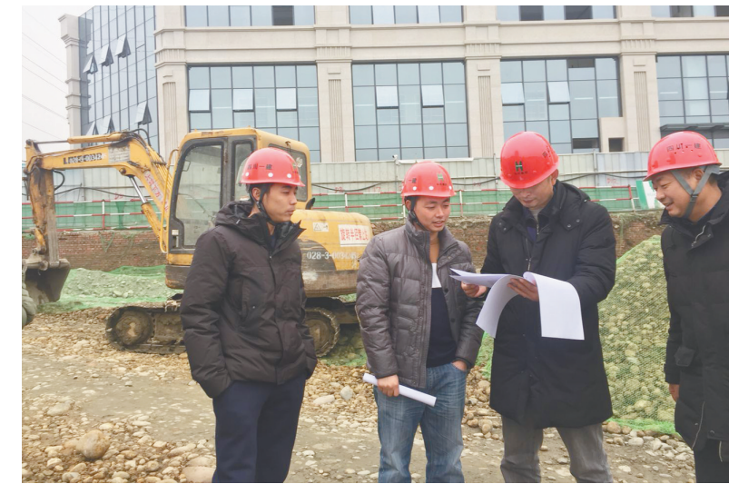
▲1月10日,四川省成都市2018-2019年蓝天保卫战冬季战役施工现场督察委员会正在查看工地内非道路移动机械的备案情况。
