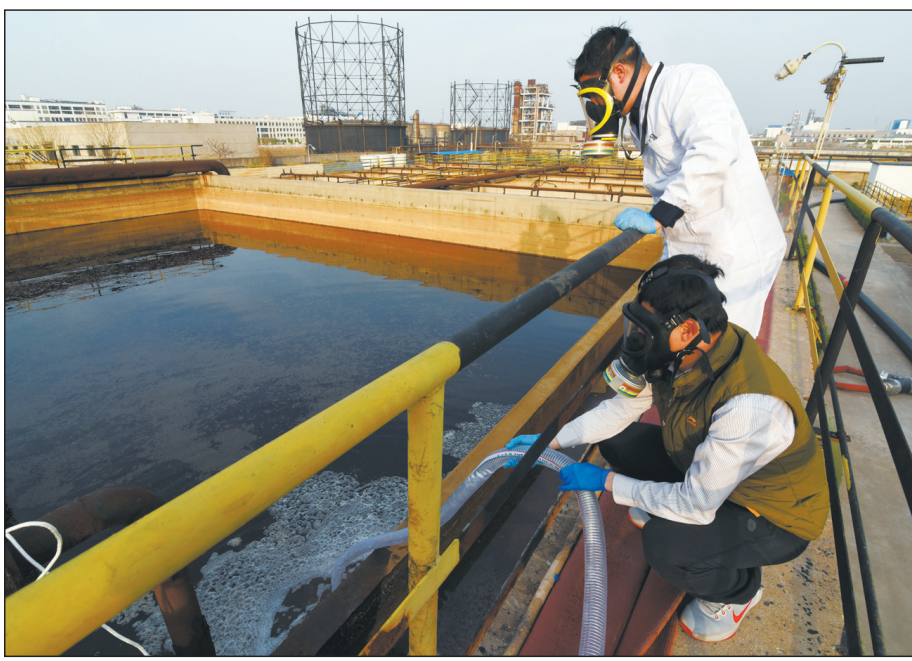
江苏响水“3·21”特别重大爆炸事故发生后,生态环境部立即从中国环境科学研究院、中国环境监测总站、南京环境科学研究所、固体废物与化学品管理技术中心、清华大学等单位调集环境监测及水、固废、土壤处理等方面30名专家,全力支持当地科学妥善处置事故。图为技术人员在陈家港化工园区裕廊石化污水处理厂厂址从爆炸核心区抽出的废水。
