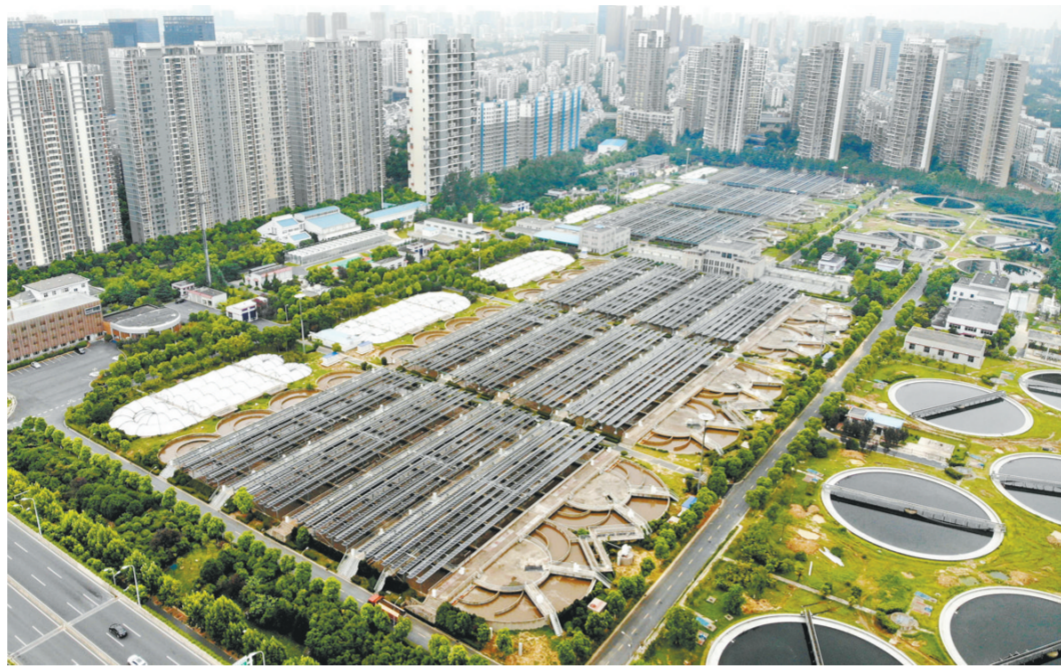
图为城市污水处理厂
