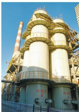
左图为山西鹏飞集团建设的3套脱硫脱硝装置,合计处理烟气量750000Nm<sup>3</sup>/h。
