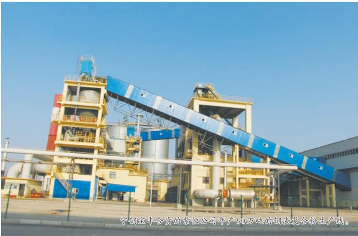
宁钢宝丰合资的紫恒公司年产90万吨的钢渣复合粉生产线。
