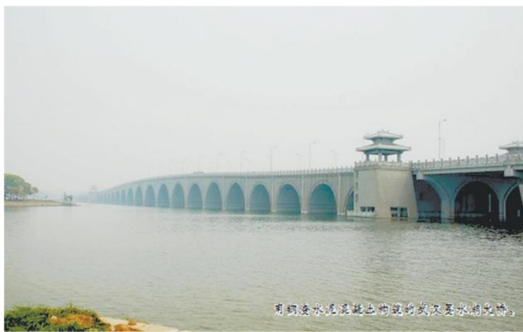
用钢渣水泥混凝土构筑的武汉吴淞湖大桥。
