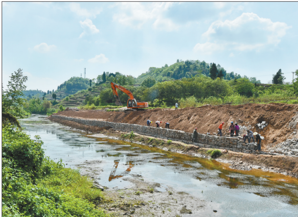
在重庆市丰都县社坛镇永兴段碧溪河流域整治工程现场,工人正在进行格宾网挡墙施工。碧溪河是丰都县唯一一条未达到水环境功能区Ⅲ类水质要求的长江北岸一级支流,去年11月丰都县投资1500万元,开始对社坛镇永兴段碧溪河3公里河道进行综合整治,确保碧溪河水清物岸绿景美。 熊波摄
