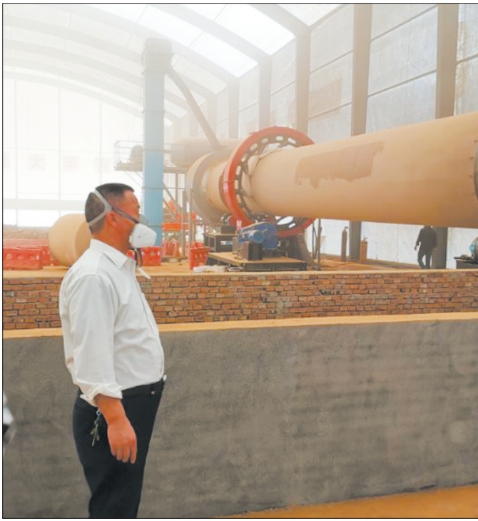
江西省新余市积极开展土壤污染防治,稳步推进原新余市前卫化工厂厂址土壤修复与治理工作。目前,项目进展顺利,污染土壤治理设施热脱附回转窑安装、土壤翻抛机调试、地下水处理设备安、地下水止水帷幕施工和抽水管井等已全部完成。黎燕平摄
