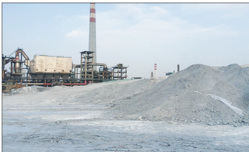
▲磷石膏堆场防尘措施不到位。
