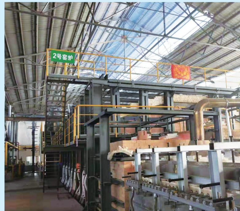
陕西省宝鸡市陈仓区育才玻璃制品有限公司进行环保提升改造,相继投资两亿元拆改4条生产线,8月底项目完成后,可年削减燃煤3.1万吨、颗粒物7.09吨、二氧化硫0.21吨、氮氧化物34.85吨。此外,企业还投资1500多万元,关停旗下麦芽加工有限公司的两台35吨燃煤供热锅炉,建设天然气集中供热项目,项目将于10月底前竣工并投入使用。
