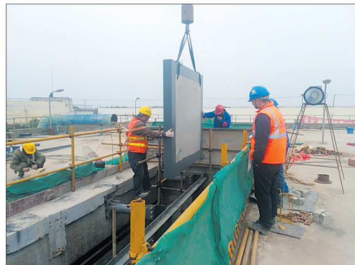
图为安装混凝土预制隔墙。
