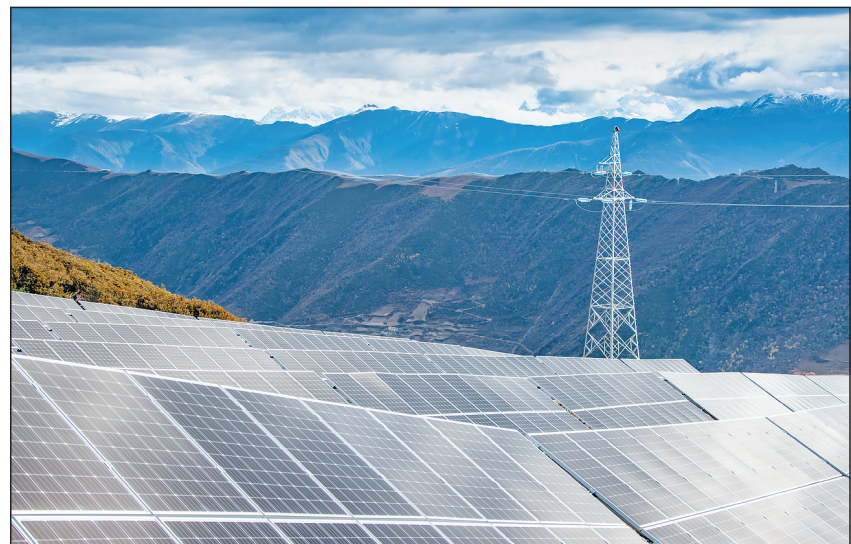
在海拔3900米的四川省阿坝州小金县大坝口村,场面壮观的光伏发电厂占据了整个山岭。小金县充分利用高海拔山顶日照强、不占林地耕地的资源优势,大力发展光伏发电项目,将生态优先和光伏扶贫有机结合起来。截至目前,共建成光伏电站5座,总装机14.1万千瓦。 人民图片网供图
