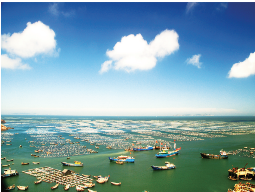
▲图为浙江省舟山市嵊泗海上牧场建设工程。
