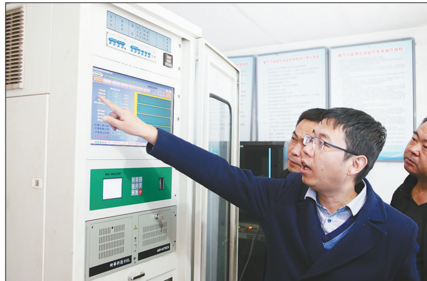
冯秀斌在金鑫焦化检查焦炉烟气在线监测设施。
