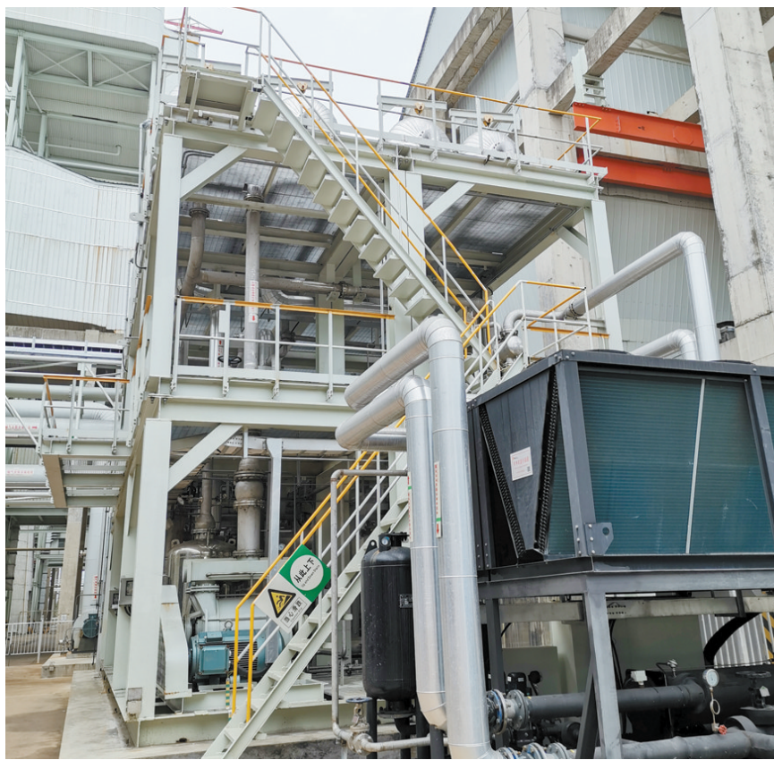
图为该项目膜分离物理工艺捕集单元。
