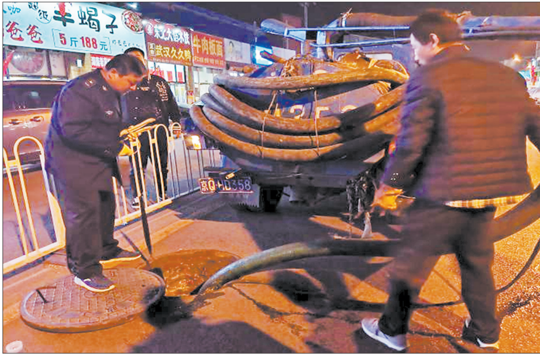
北京市朝阳区生态环境局近日接到有企业擅自排污的举报后,立即派员赶到现场。当天晚19时,应急监测人员对抽粪车所排污水采样。结果显示,污水中氨氮和化学需氧量均超过北京市水污染物排放标准。 因案件涉嫌私设暗管排放水污染物,犯罪嫌疑人张某某目前已被依法移交当地派出所。 谢娟娟供图
