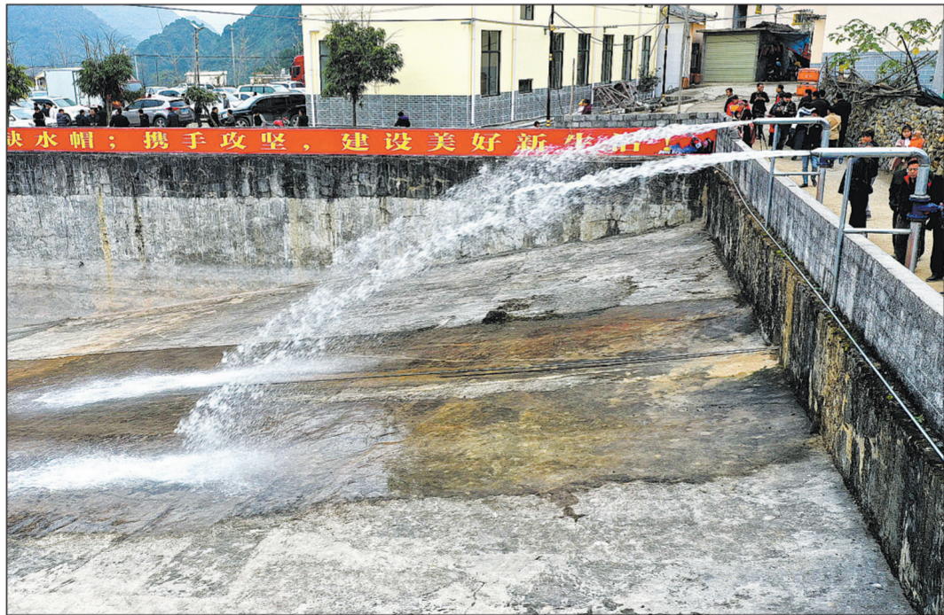
12月28日,清澈甘甜的东山水成功引上险峻的东山,涓涓细流直抵群众家中,困扰广西壮族巴马瑶族自治县东山乡群众多年的“水愁”迎刃而解。总投资6829.44万元的东山乡供水工程提水扬程为525米,最高落差为744.6米,输水管网长达256公里,解决了东山乡千桥、江团等7个村,以及大化瑶族自治县北景镇弄冠村16335人的多年饮水难题。 人民图片网供图
