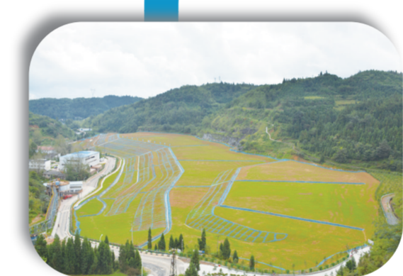
金兴公司整改后现状
