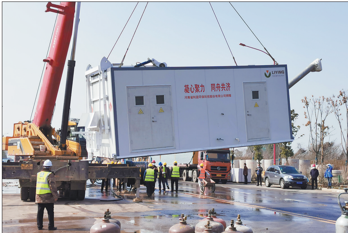
疫情发生以来,湖北省武汉市生态环境局始终坚守一线,主动作为。图为武汉市生态环境局和江夏区生态环境分局工作人员正在协调雷神山医院医疗废物微波消毒炉吊装工作。李宗泽摄
