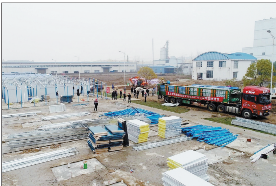
2月2日,由湖北华信中正检测技术有限公司和河北丰源环保科技有限公司联合支援的一套医疗废水专业处理设备抵达湖北省荆州市“小汤山”医院。当这套医疗废水专用设备运抵洪湖市后,企业技术人员立刻和建设施工方对接,指导设备安装。据了解,这套设备可日处理医疗废水800吨,为抗击疫情做好保障。
