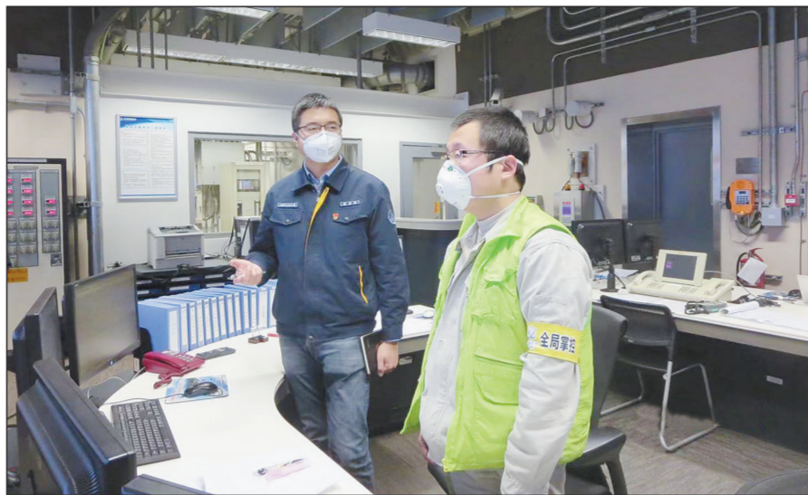
图为监督员正在核电站开展现场监督。 华东监督站供图
