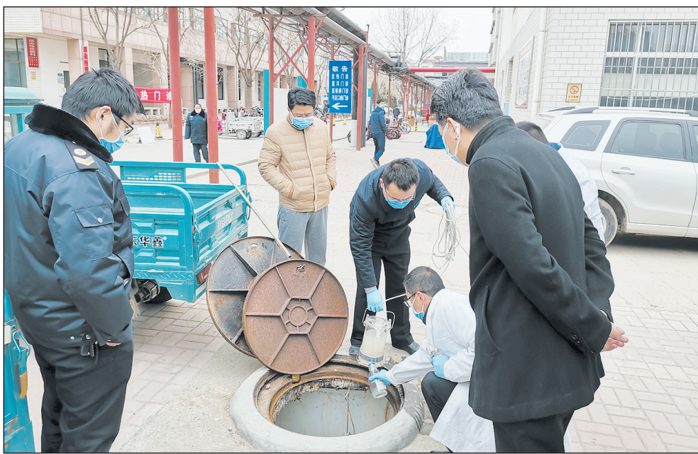
新冠肺炎疫情防控阻击战打响以来,山东省德州市生态环境局齐河分局生态环保铁军迅速行动,每天对全县城区、乡镇所有医疗机构的医疗废物收集、暂存、转运、处置、台账管理及废水处理设施运行、外排废水情况进行全方位监管。图为齐河分局应急突击队执法人员对涉疫情废水处理设施运行情况进行现场检查。
