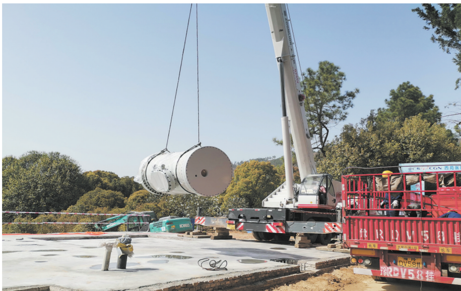
图为电子加速器主体设备抵达现场后进行吊装。
