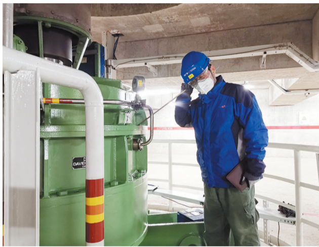
图为核电站维修人员开展现场检修工作。 宁德核电站供图
