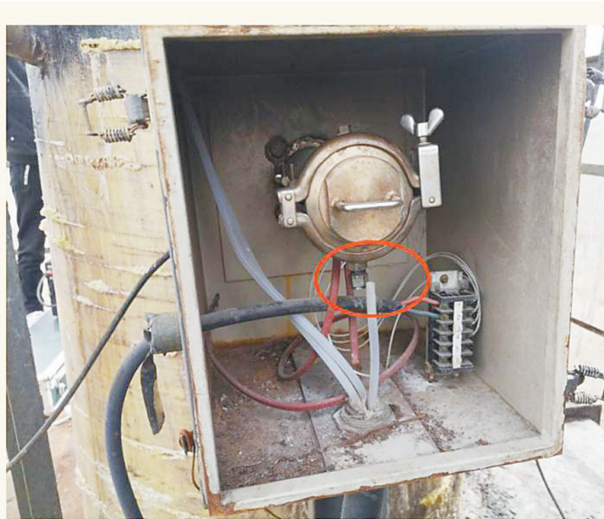
山东省济宁市生态环境保护综合执法支队近日在网上巡查时发现,泗水县华盈医用包装材料有限公司外排废气在线监测数据异常,氧含量接近21%,二氧化硫和氮氧化物浓度接近于零。执法人员现场检查发现,在线监测采样管被人断开,在线监测设施采集的全是空气。图为被人为断开的采样管线。周雁凌 季英德摄
