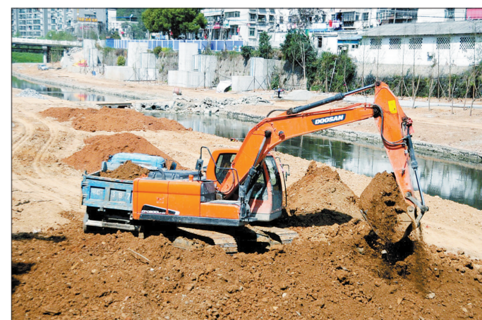
位于湖北省十堰市张湾区神定河下游的主河道水质净化前处理及调蓄配水工程建设项目近日全面复工。施工现场机声隆隆,大型挖掘机、装载机正在对主体工程进行土石方回填,计划5月底完工。
