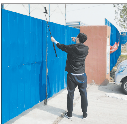
时间:4月18日上午10:01 地点:天津市滨海新区河南路1826号中建路道路施工工地
