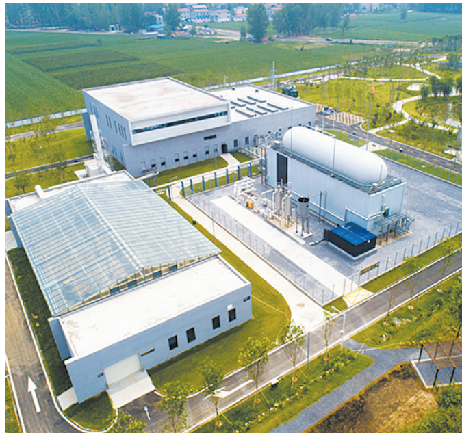
中持股份承担的河南商丘睢县环境整体改善一期工程PPP项目中的关键子项目——睢县第三污水处理厂。
