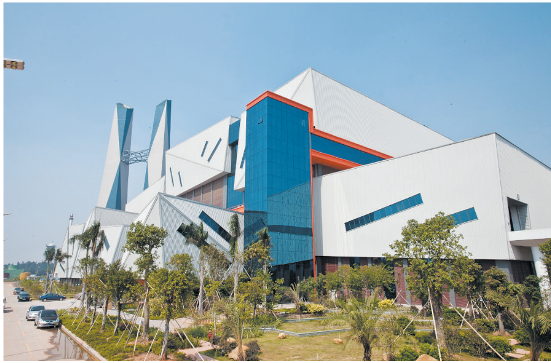
瀚蓝环境下属南海区垃圾焚烧发电项目。
