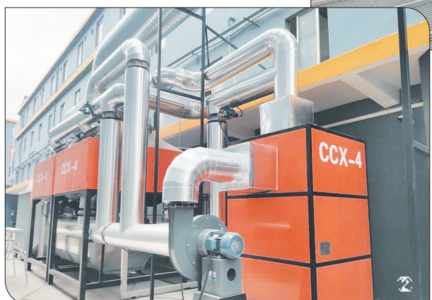
①喷漆车间的全密闭收集废气系统。 ②喷漆废气经密闭车间的管道收集到催化燃烧装置,再经催化燃烧处理后达标排放。
