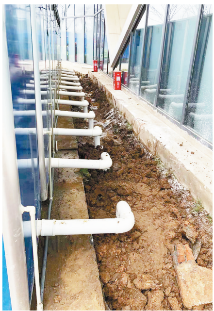
图为白马驿站方舱医院临时污水处理设施施工现场。
