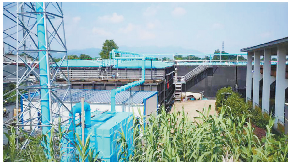
图为浙江省嵊州市万年亭泵站污水处理项目(20000m³/d)运营现场。
