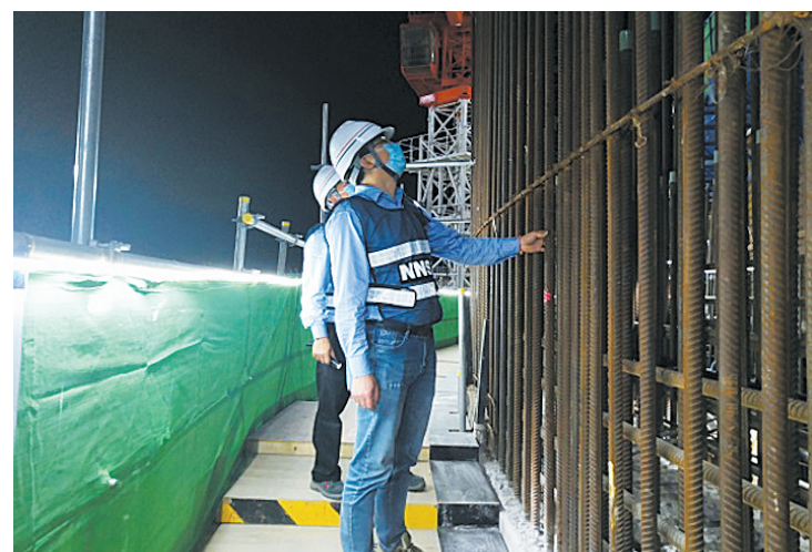
近期,生态环境部华东核与辐射安全监管站对漳州核电厂夜间施工开展多次随机抽查,夜间现场监督已常态化。 王艺湖摄
