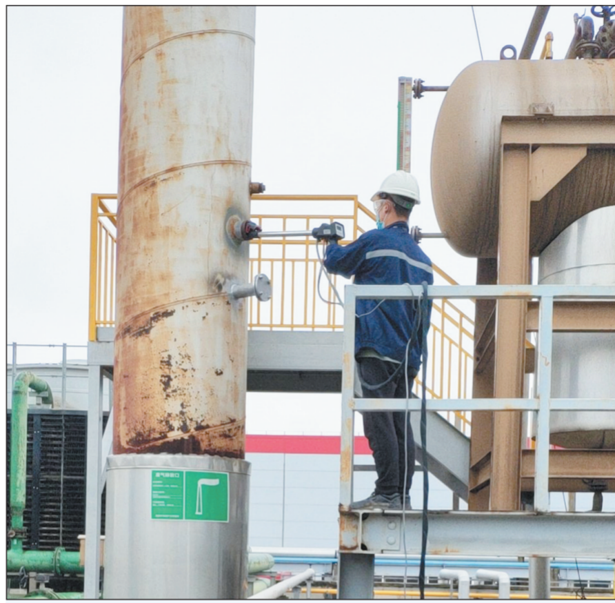
第三方环保服务机构上海博优测试有限公司技术人员正在对某企业内部废气排放管进行勘察。
