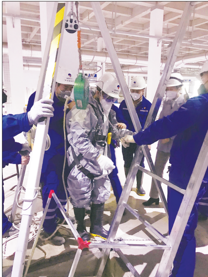
操作人员头戴安全帽,身穿防护服,佩戴正压式空气呼吸器,在监护人员辅助下,准备检查生物池曝气盘。 刘瑛良摄
