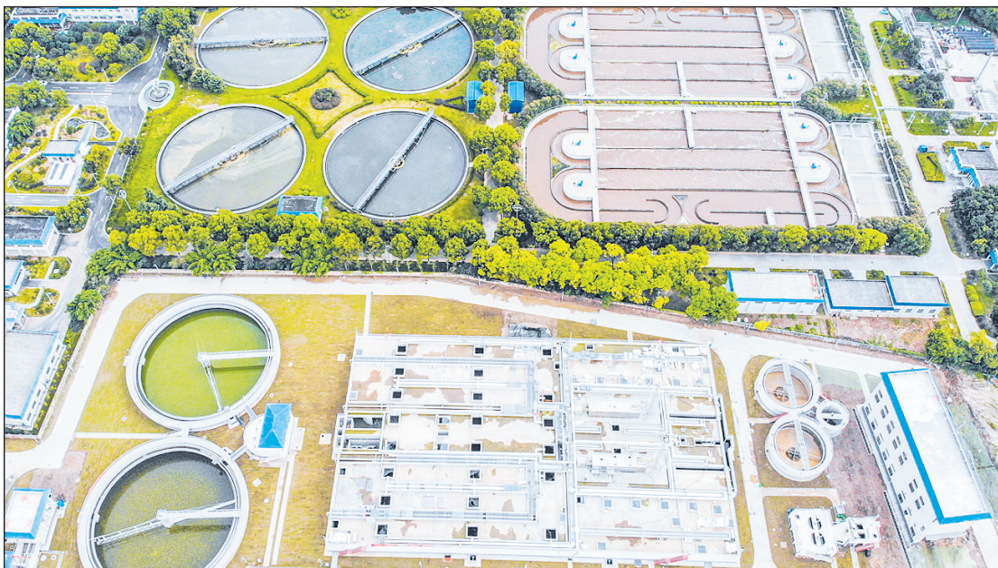
7月30日,湖北省荆州市红光污水处理厂二期工程调试运行。工程的投运可实现新增日处理生活污水5万吨、排水20万吨的能力,出水水质按照国标一级A标准执行,污水处理总服务面积达52.5万平方米,服务人口约20万人。 人民图片网供图
