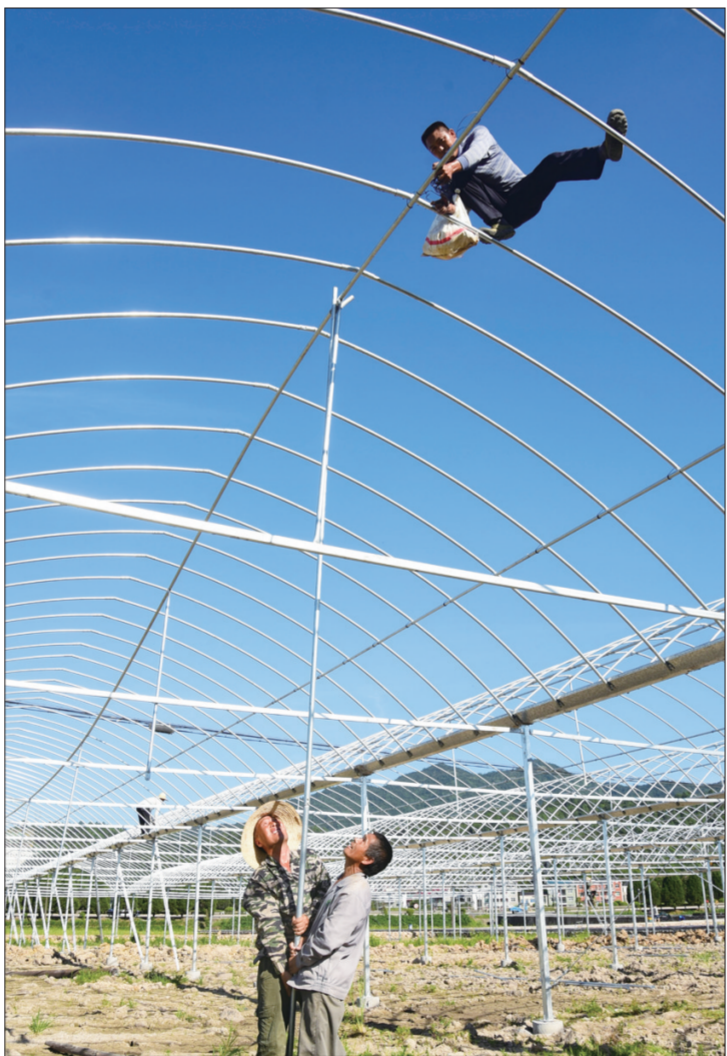
8月2日,在浙江省建德市寿昌镇山峰村田间,50多名工人正冒着高温酷暑天气,抢时间,赶进度,建设精品农业生态园。据介绍,该镇今年对山峰村630多亩土地开展精品农业生态园建设,以点到面带动市镇全域旅游发展,以休闲旅游带动经济发展,助力乡村振兴。 人民图片网供图
