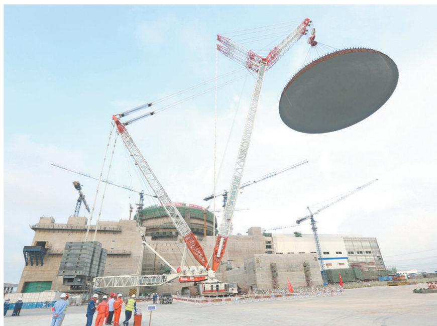
近日，“华龙一号”全球示范工程——福清核电6号机组顺利实现外环安全壳穹顶钢模板吊装，标志着“华龙一号”在建设领域得到进一步提升，为“华龙一号”机组后续批量建设积累了宝贵的施工经验。
