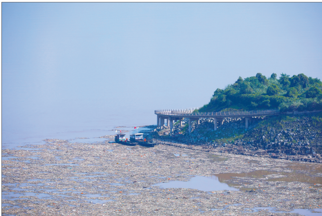
8月2日,在三峡大坝库首,13艘大小船舶、近60人的清漂队伍正在用机械打捞和人工打捞相结合的办法,清理三峡库区上游洪峰带来的漂浮物。漂浮物打捞上岸后,被送至种归水泥厂做燃料,从而实现垃圾无痕处理。据湖北省种归县生态环境部门介绍,2019年三峡库区无痕处理漂浮物9万立方米。 人民图片网供图
