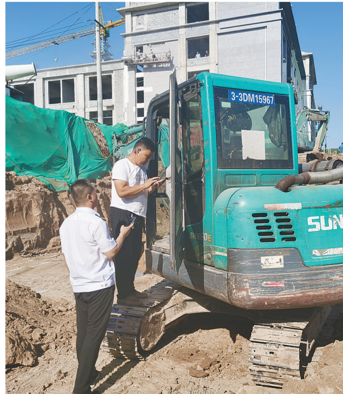
依法加强非道路移动机械污染排放管控,河北省邯郸市生态环境局鸡泽县分局对辖区内所有建筑工地非道路移动机械开展监督检查,对未进行备案、冒黑烟排放的非道路移动机械坚决清出施工现场。
