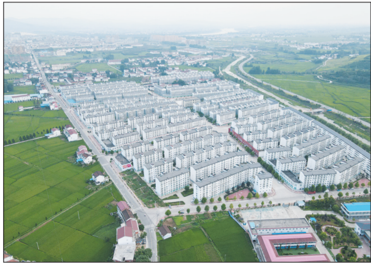
洋县李家村生态移民新村。全县建成34个集中安置点,完成异地扶贫搬迁3510户,有效保障了困难群体住房安全。
