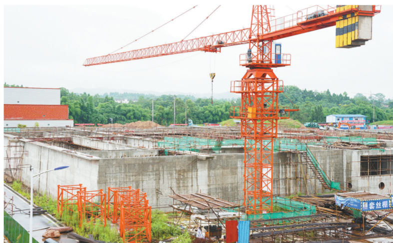
图为大足城区污水处理厂,处理能力4.5万吨/日。目前正在开展三期3万吨/日处理能力扩建,预计今年10月投入试运行。
