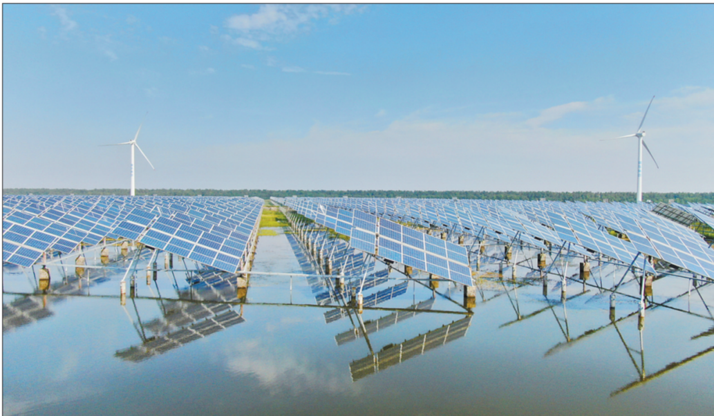
江苏省东台市不断推进“风、光、渔、水”立体开发布局,形成“上有风力发电、中有光伏利用、下有水面养殖”的“风光渔”互补立体开发模式,建成了国内最大的“风光渔”一体化电站、全球单体规模最大的新能源产业基地。 人民图片网供图
