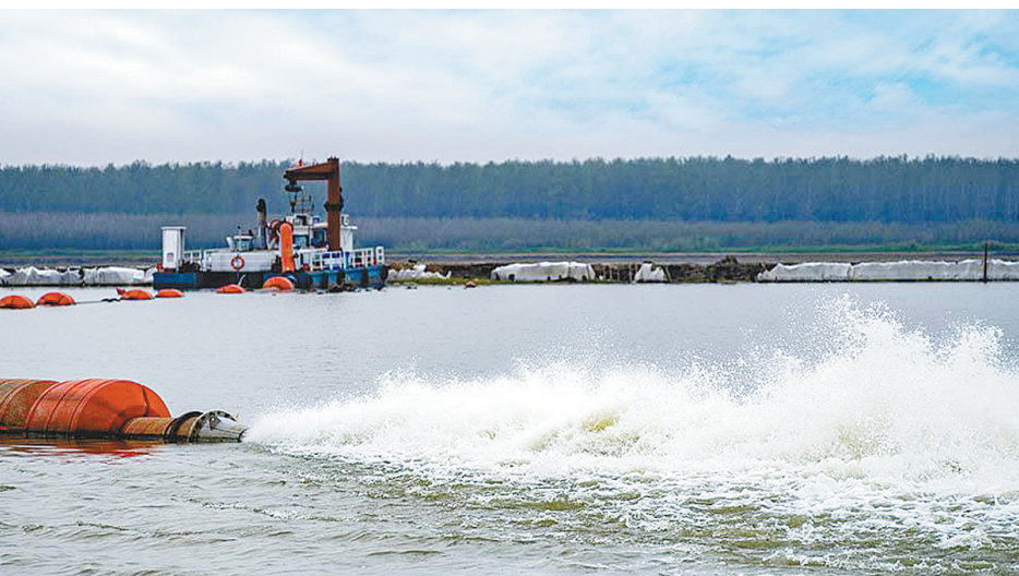
河南省驻马店市宿鸭湖水库清淤扩容工程施工现场,9艘大型吸式挖泥船正在进行清淤作业。宿鸭湖水库清淤扩容工程是我国首个大型水库清淤试点工程,总投资31.58亿元,项目建成后将成为集防洪、灌溉等多功能于一体的大型水利枢纽工程,可保障沿线及下游80万亩农田灌溉用水,有效改善宿鸭湖生态环境,为全国大型水库清淤扩容工作提供经验。人民图片网供图
