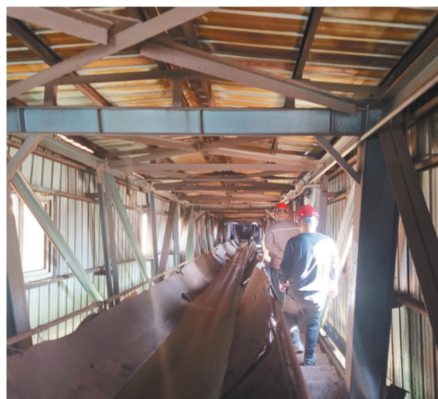
唐山市生态环境局日前制定印发《唐山市2020年秋冬季污染防治攻坚战实施方案》,开展“解剖式”执法检查,指导企业及时整改环境隐患,严肃处理环境违法问题。图为唐山市执法人员深入某废料综合利用企业物料运输廊道内部,查看无组织排放管控情况。
