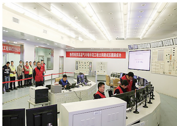
近日,我国具有完全自主知识产权的国家科技重大专项华能石岛湾高温气冷堆核电站示范工程1号反应堆冷态功能试验一次成功。这是继10月19日2号反应堆冷态功能试验一次成功后的又一重大节点胜利,标志着示范工程顺利完成双堆冷态、核岛核心系统建设质量得到全面检验,提前14天完成这一年度目标任务。 华能摄
