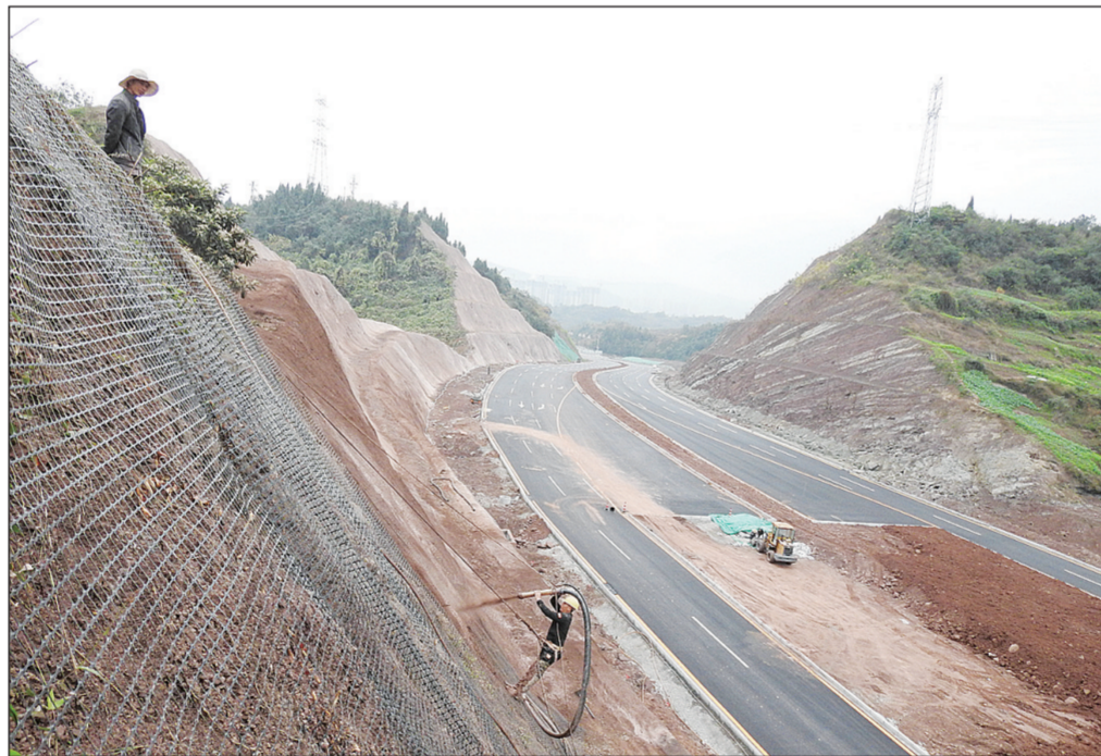
四川省达州市全面启动矿山矿坑及竣工公路沿线生态修复工作,采取生态科技助力的方式,由技术人员组成一支支特殊“美容师”队伍,在原本光秃秃的陡峭岩壁上清坡、铺网、喷土、栽种,确保把公路建成绿色公路。 人民图片网供图
