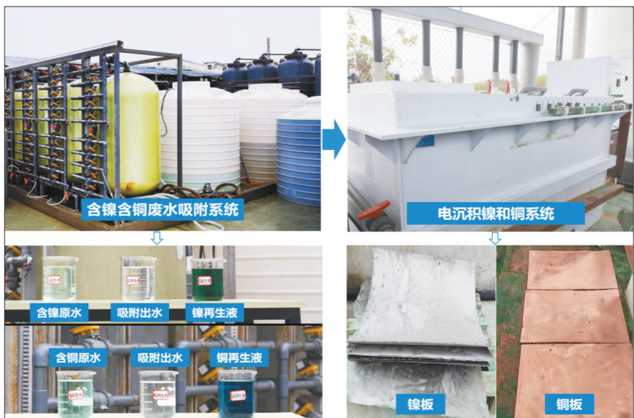
基于吸附—电沉积技术的电镀废水资源化示范工程及得到的高纯度镍板和铜板
