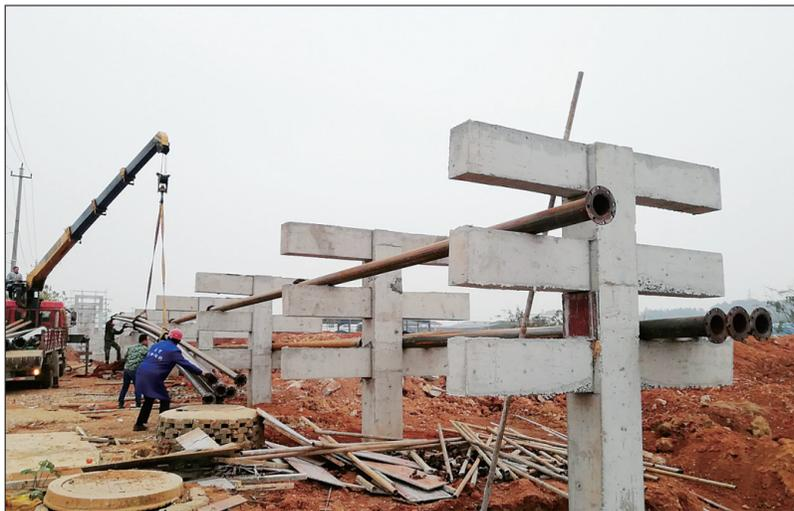
今年以来,江西省宜春市上高县启动化工企业污水管网“一企一管”改造,为园区12家化工企业一对一接入污水管网,修建地面管廊,在管廊上架设明管,通过空中明管输送污水统一进入辖区工业园污水处理厂处理,此举可以更好地监督企业污水排放行为,杜绝污水“泡冒滴漏”现象。冯万 熊江峰摄
