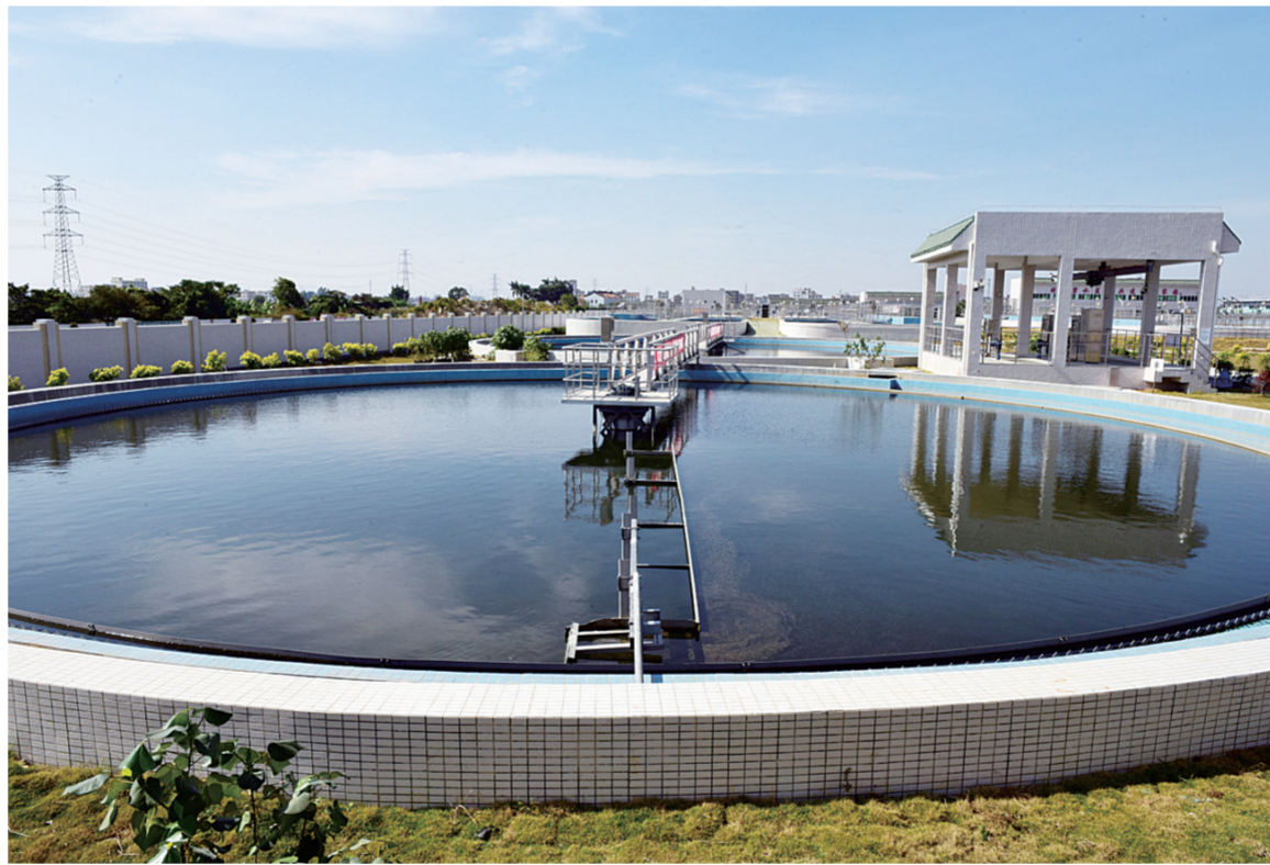
图为污水处理厂。
