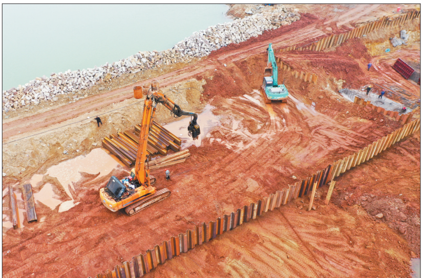
近日,在江西省吉安市永丰县七都乡境内恩江河治理工地上,工人正在加紧施工作业。近年来,永丰县不断推进河道流域生态综合治理,通过工程建设和“清四乱”整治,修复和优化河道流域水生态环境。
