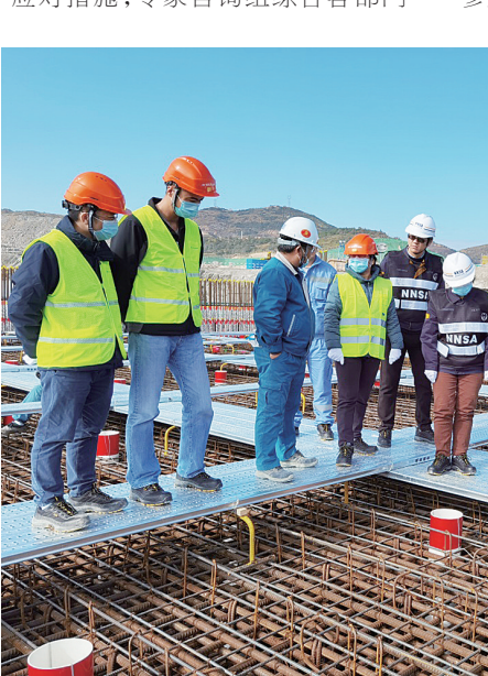
生态环境部华北核与辐射安全监管站(以下简称“华东监督站”)近日组织检查组对浙江三澳核电站1号机组核岛基础浇筑第一罐混凝土(FCD)前准备情况进行核安全检查。重点检查了质量保证大纲实施、监理单位体系运作有效性、FCD前现场施工准备以及经验反馈体系运转等方面,现场查看了核岛筏基、混凝土搅拌站及试验室、钢筋加工区等区域。针对发现的问题,华东监督站依法从早提出整改意见,推动现场积极整改落实。图为检查现场。
