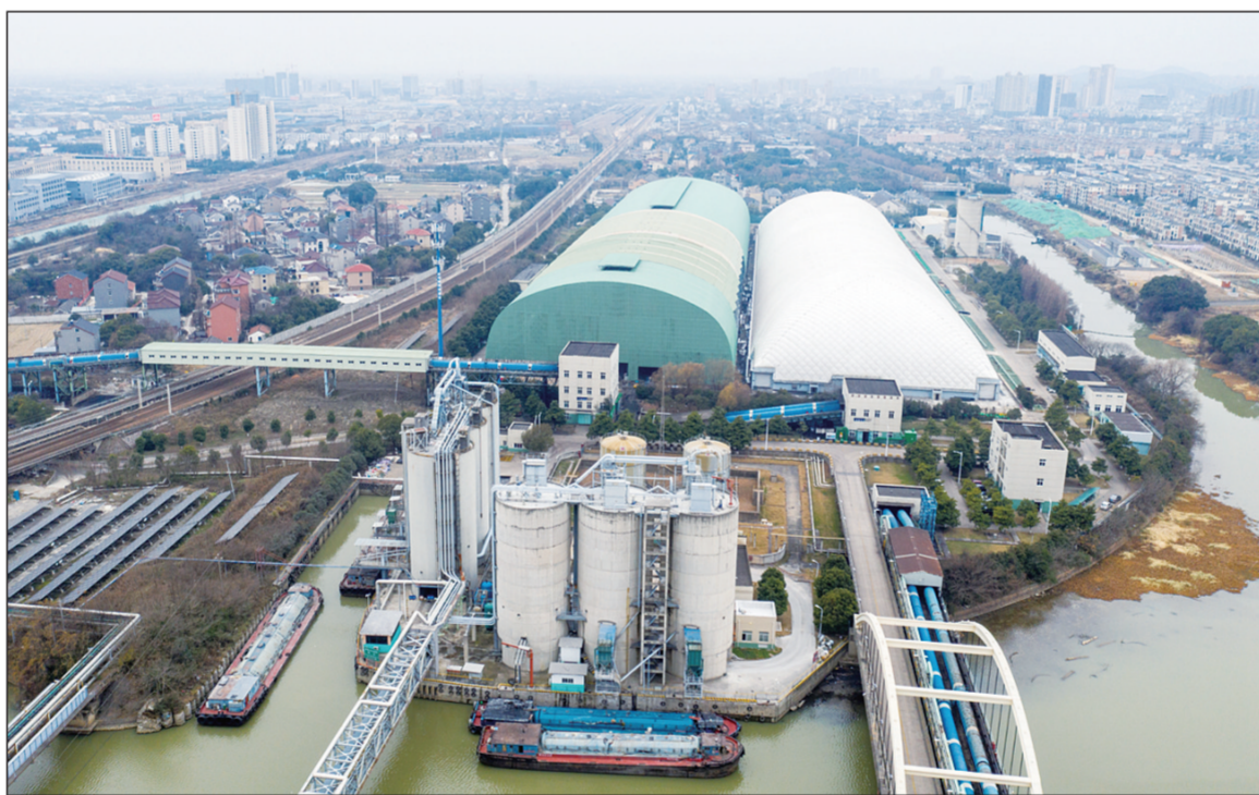
1月6日,浙江浙能长兴发电有限公司煤场封闭改造项目雄姿展现。这是浙北地区首个煤场封闭改造项目,于日前正式投运。项目投资近1亿元,占地5万余平方米,改造后的气膜煤场和钢结构煤场可储存燃煤15万吨,将完全隔绝扬尘,避免雨水冲刷可能造成的污染,极大减少粉尘污染,为社会发展和居民生活提供清洁、稳定的能源。 人民图片网供图
